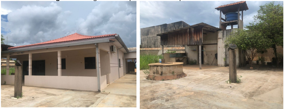
Figura 17: Abrigo no município de Costa Marques: Área externa
