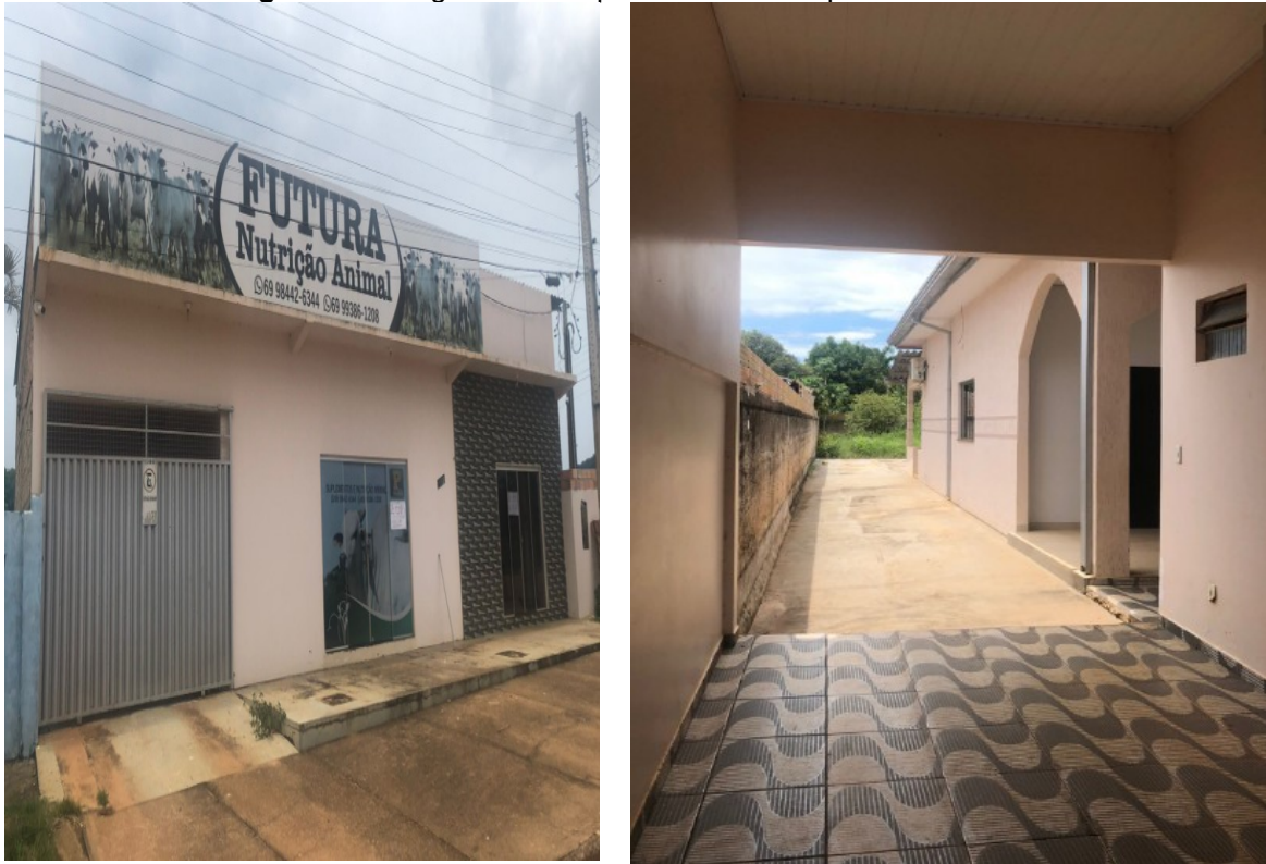
Figura 16: Abrigo no município de Costa Marques: Área externa
