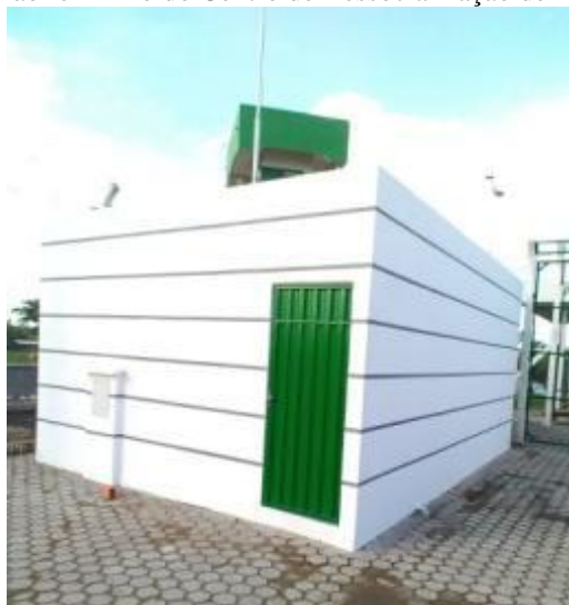
Figura 2 – Pavilhão feminino do Centro de Ressocialização de Alvorada do Oeste.
