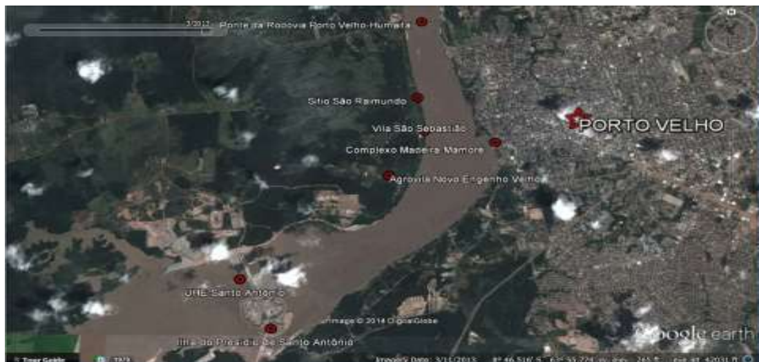
Figura 1- Localização da Usina de Santo Antônio
